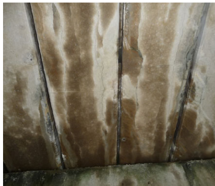
PCプレテン床版 ひびわれ
