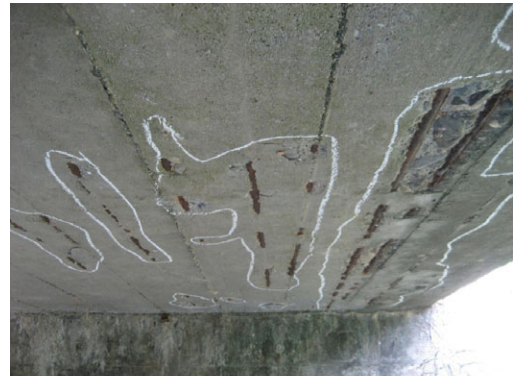
RC床版 剥離・鉄筋露出
