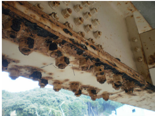
鋼桁 腐食
