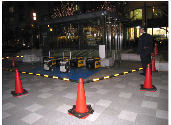
地上部に設置した発電機、アンテナ
