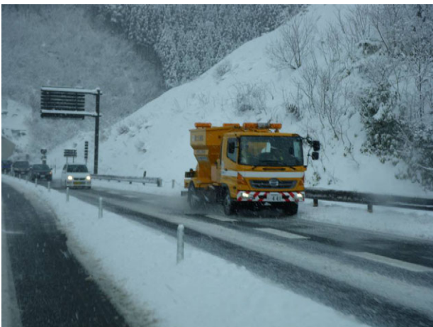
凍結防止剤散布作業
