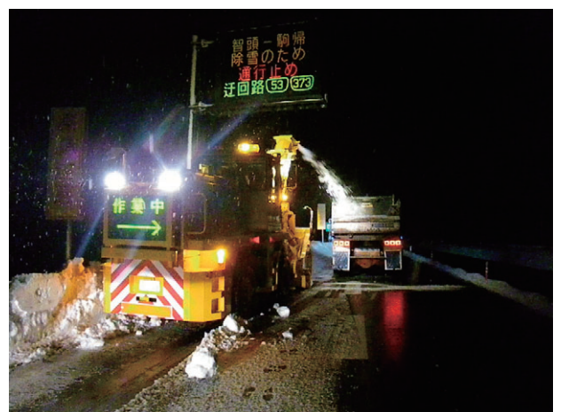
運搬排雪作業状況
