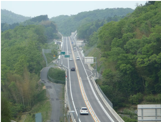
湯郷温泉インターチェンジ付近 (平成24年3月供用開始)
