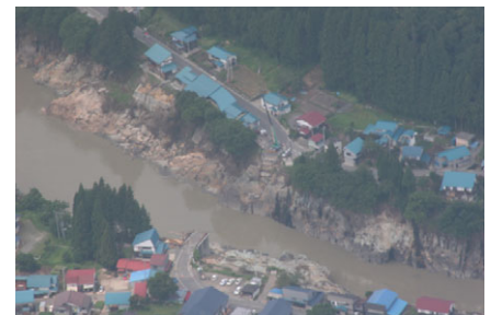
福島県大沼郡金山町「R252 二本木橋 落橋」
