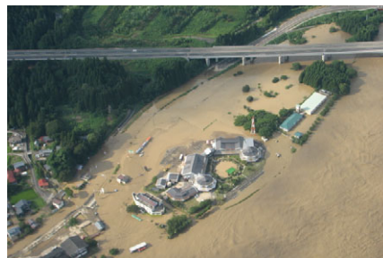
新潟県阿賀町 冠水状況
