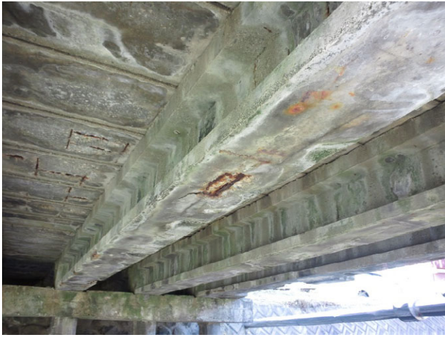
市内のある橋梁の状況
