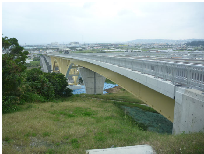
b) 旧塗装系（ポリウレタン樹脂）の橋梁
