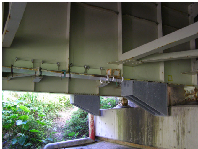
a) 塗装鋼板設置状況
