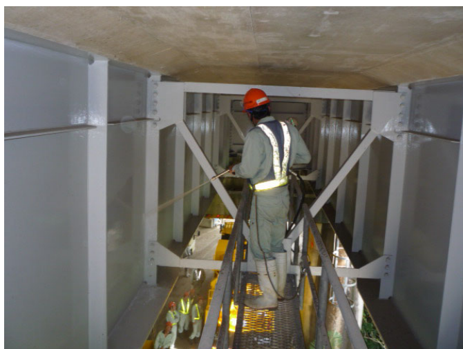
a) 高圧洗浄による橋梁洗浄
