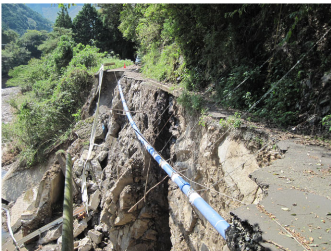
田辺市中辺路町福定（中辺路地区）、被災延長 L = 43 m
