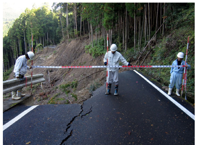
市道災害の現地測量調査 (田辺市本宮町大居（本宮地区）、被災延長 L = 102 m)
