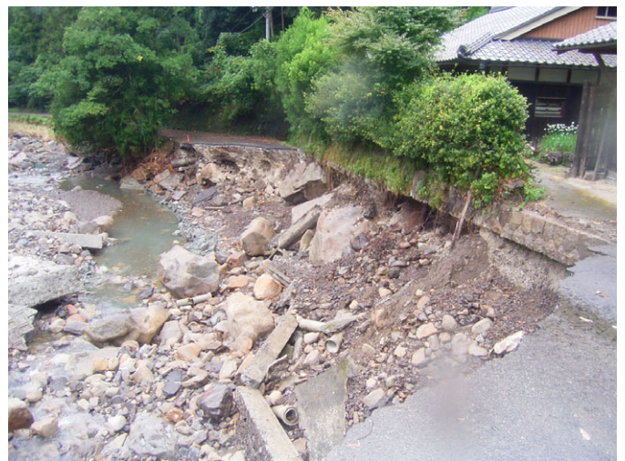
田辺市中辺路町高原（中辺路地区）、被災延長 L = 46 m
