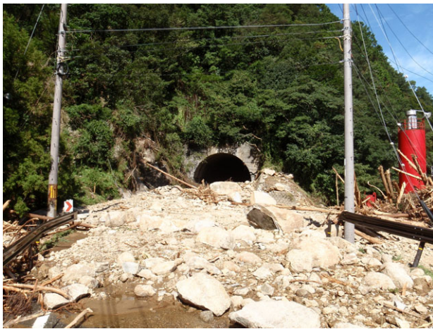
被災直後の国道 168 号（吊鐘トンネル：新宮市）
