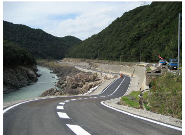
応急対策後（10 月 4 日開通）
