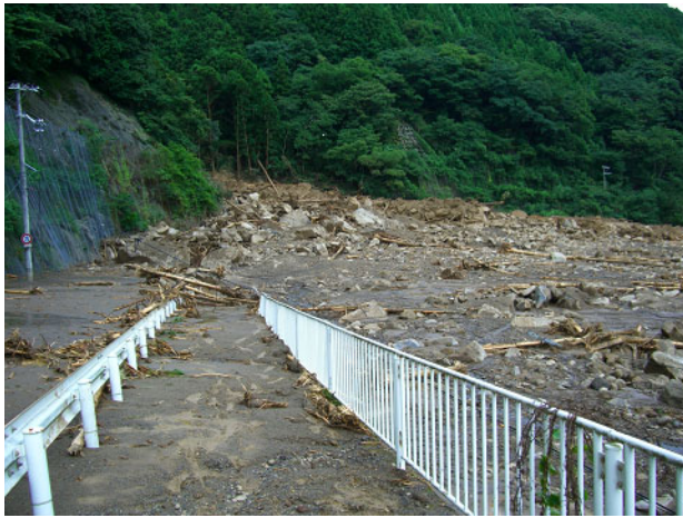
被災直後の国道 311 号（田辺市中辺路町真砂地内）
