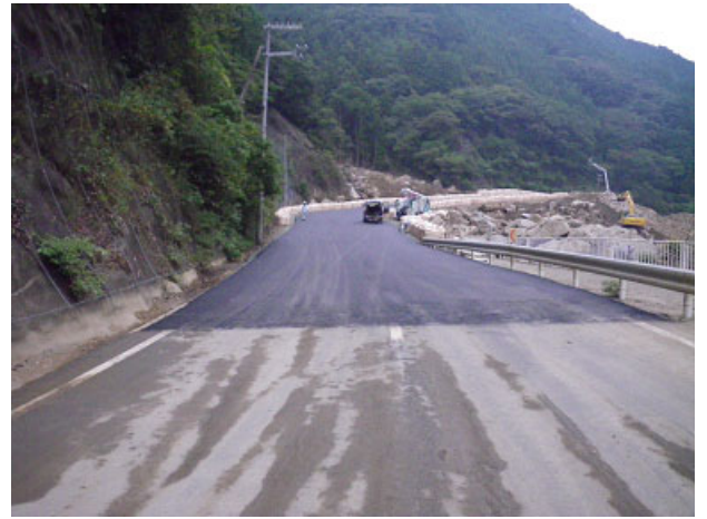
応急対策後（10月4日開通）
