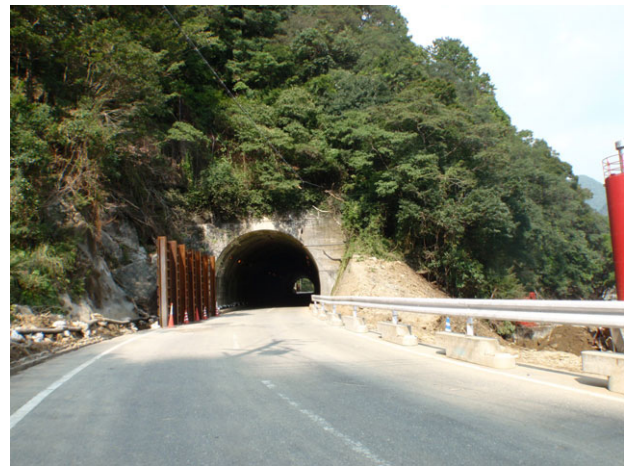
応急対策後（10 月 14 日開通）
