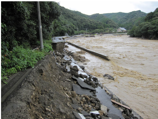
被災直後の一般県道たかの金屋線（日高川町高津尾地内）
