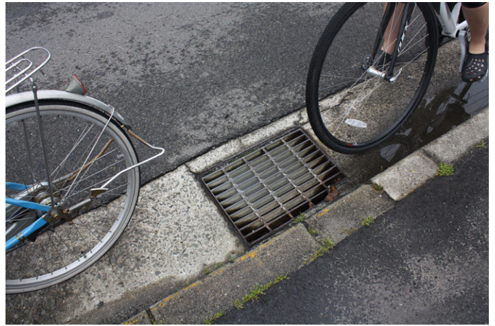
タイヤより大きいグレーチングの溝
