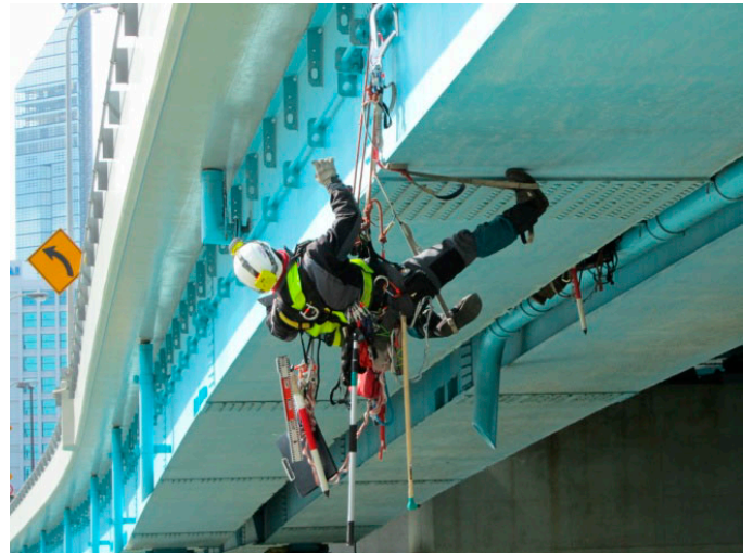
写真-2 新たな点検手法「ロープアクセス」 (構造物の近接手法の改善例で、従来コストの約 1/6)
