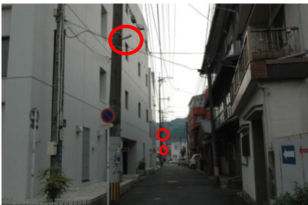
取替後（LED照明昼間）
