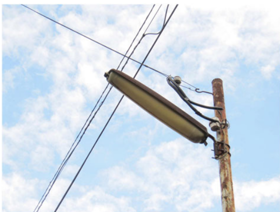
取替前（蛍光灯照明）
