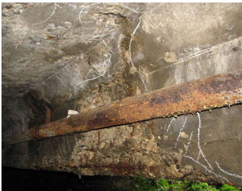
図-9 外桁の損傷状況
