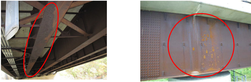
図-8 耐候性鋼材の異常な腐食の例
