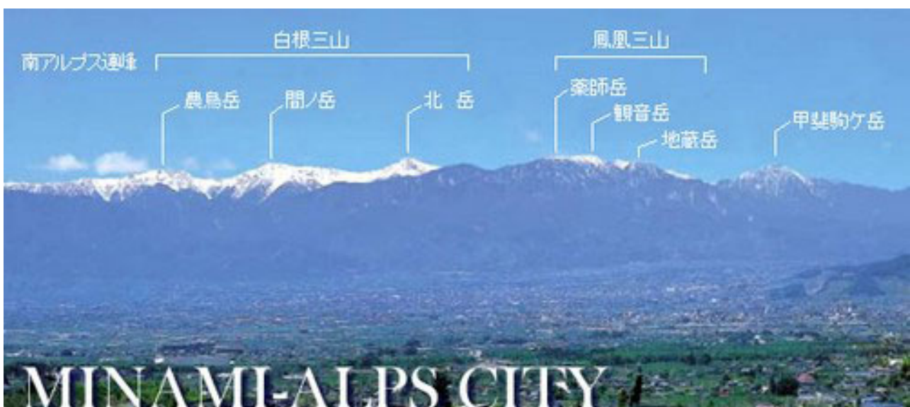
写真1 南アルプス連峰を背後に広がる南アルプス市
