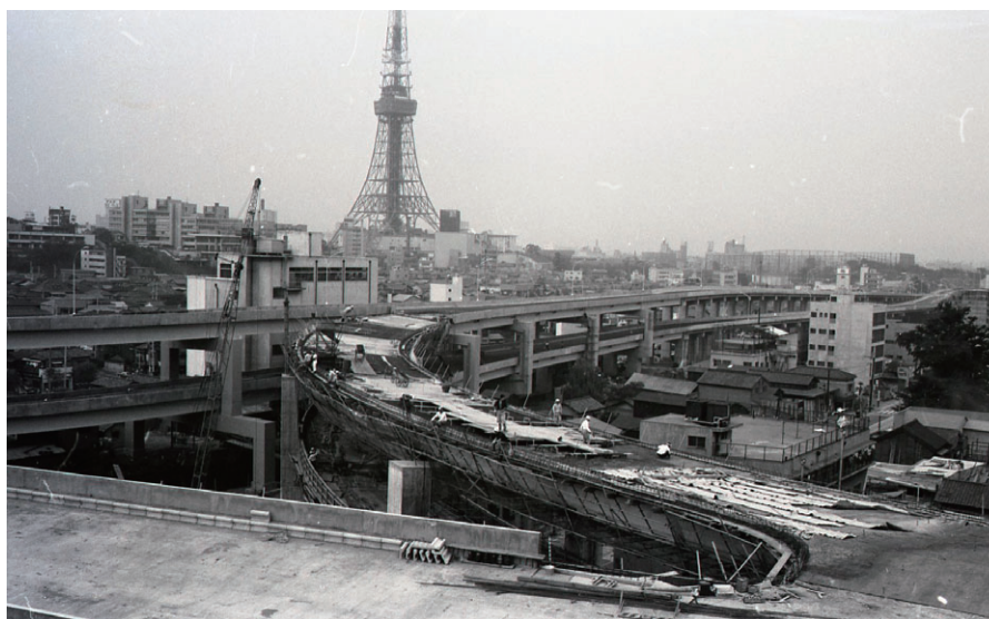
昭和 42 年 6 月 環状線建設現場
