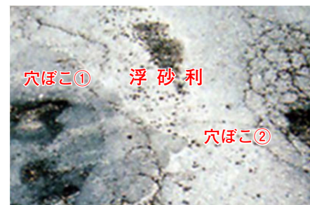
写真3 浮砂利③拡大写真
