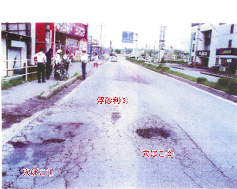
写真1 事故現場全景写真
