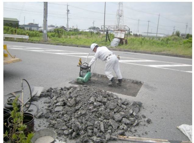
写真4 舗装修繕期同伴作業状況
