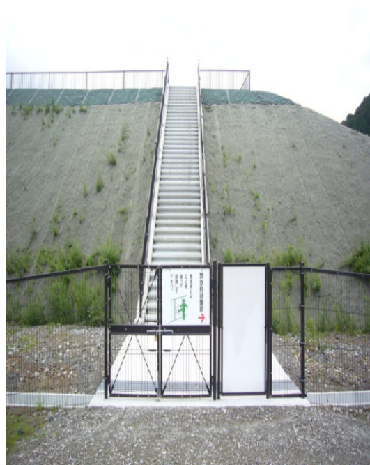
図－8 緊急避難階段として整備された箇所 （北牟婁郡紀北町便ノ山地区）
