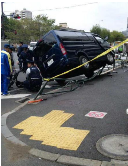
車両横転によるガードレールの破損
