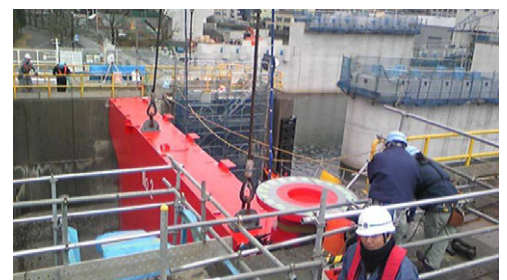
水門の工事現場での進捗報告に活用
