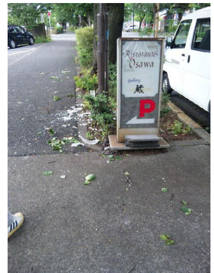
台風による街路灯の破損
