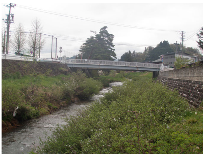
下流より上流全景左岸より
