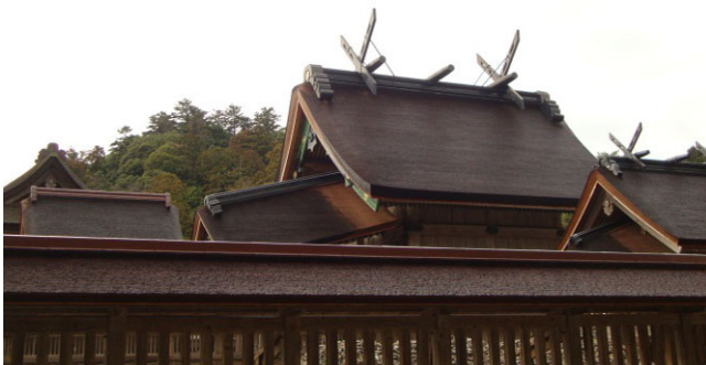
檜皮葺の葺き替えを終えた御本殿の大屋根
