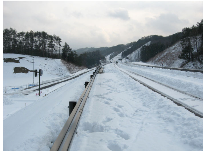
本線上の積雪状況 H25.1.29
