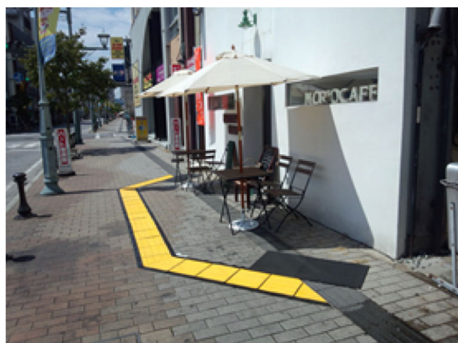
仮設点字ブロックの敷設 (1)
