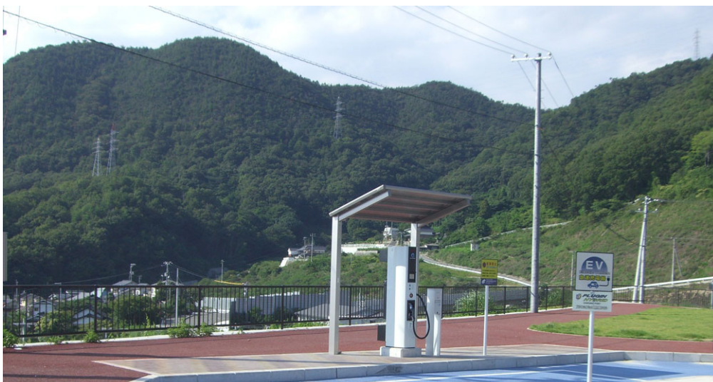
・国道 2 号 道の駅みはら神明の里 (広島県)
