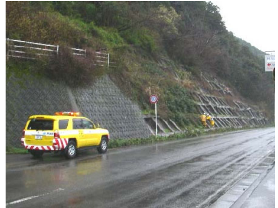
写真－1 日常点検状況
