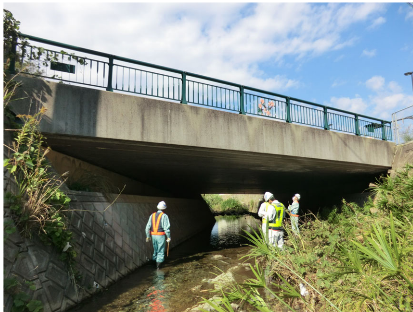
写真－4 道守参加の橋梁点検状況
