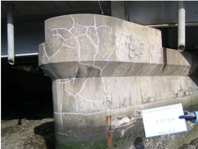
写真-2 コンクリート橋の損傷状況 (アルカリ骨材反応)
