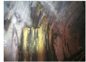
ひび・漏水が発生しています
