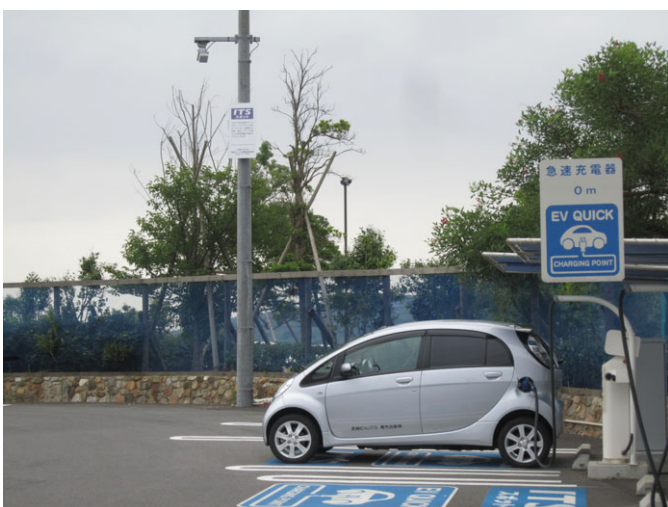
写真-6 急速充電器と ITS スポットの併設
