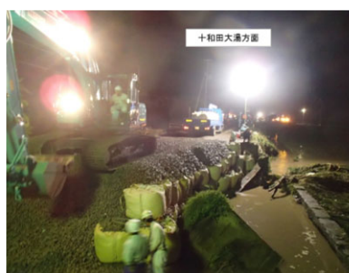
8月10日 2時 (応急工事)
