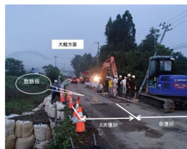
8月11日 4時 (応急工事)
