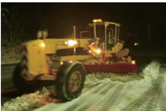
写真2 夜間の除雪作業
