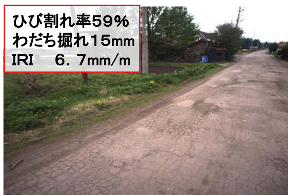
写真-5 舗装現況と計測された路面性状値
