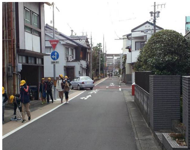
写真② カラー舗装実施後
