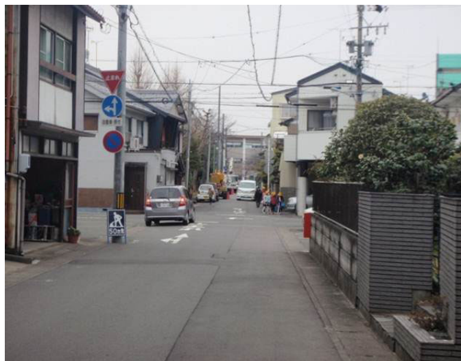
写真① カラー舗装実施前
