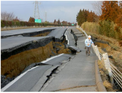
道路の崩壊（常磐自動車道那珂 IC 付近）
