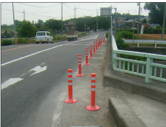
ラバーポールの設置
