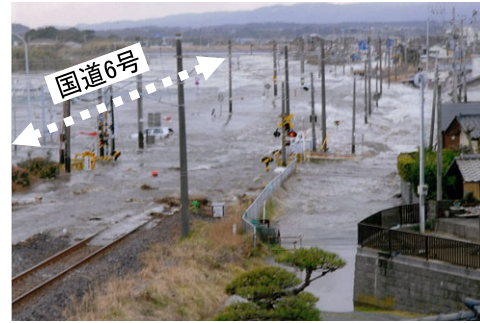
津波浸水（国道6号 北茨城市磯原）
