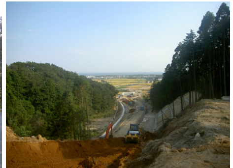
津波代替路の整備
