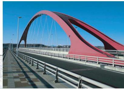
25 多摩大橋通り
