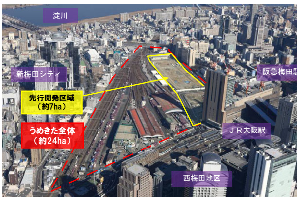
《航空写真（工事着手時）》
