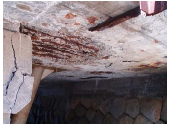
<橋梁の損傷事例>
