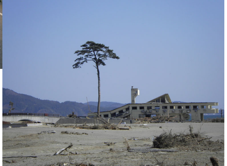
写真－2 被災前と被災後の状況（陸前高田市：一本松周辺）
