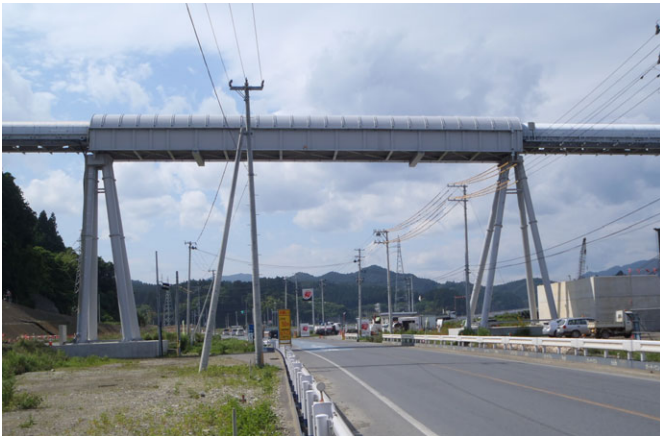
写真-5 国道45号横断部ベルトコンベヤ設置状況
