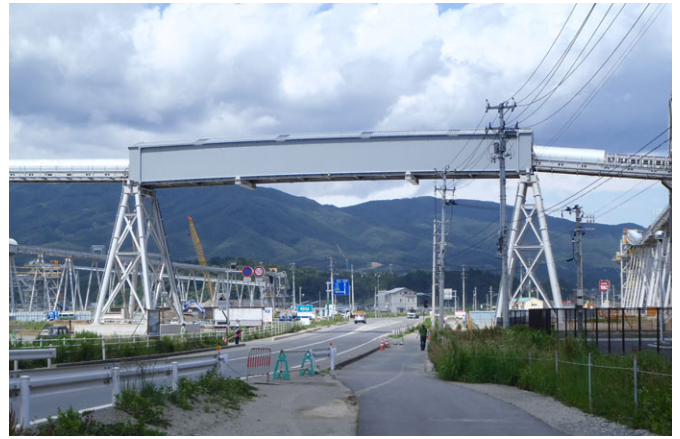
写真-5 国道45号横断部ベルトコンベヤ設置状況
