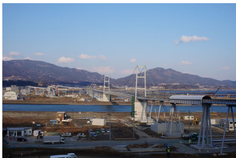
写真-4 仮設吊り橋（主塔 TP+42.6m 塔柱間 220m）
