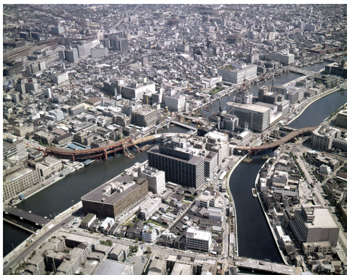
建設中の中之島S字橋
