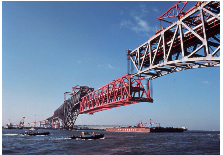
港大橋吊桁部の一括吊上げ架設
