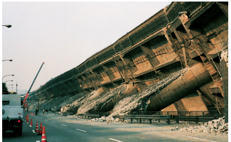
倒壊した 3 号神戸線
