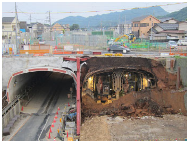
写真2 複合アーチ断面・開放型シールド機を採用した城山トンネル
