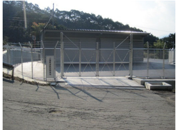
写真－2 完成した道路啓開基地
