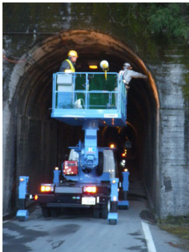
写真-1 トンネル点検状況
