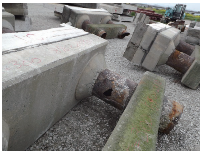
腐食した橋脚を切断し撤去
