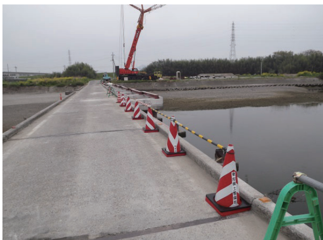
潜水橋撤去工事の様子
