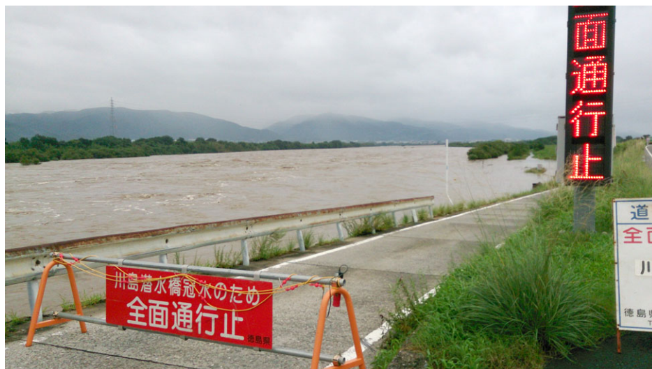
< 出水時（通行止め措置状況） >
