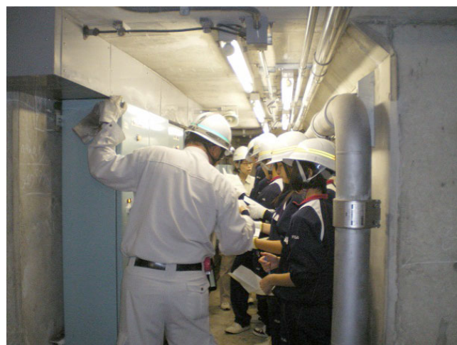
【共同溝現場状況】
