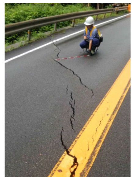
（高知）国道32号 地すべり
