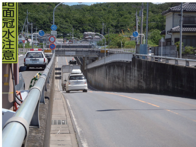
通行止め解除後の通行状況
