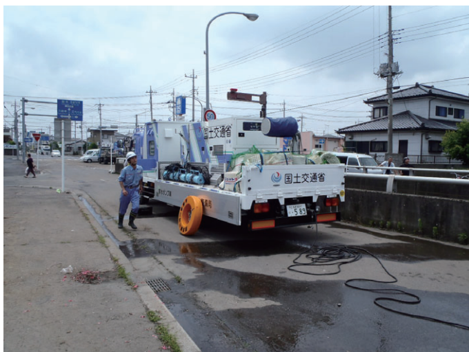
国土交通省所有の排水ポンプ車
