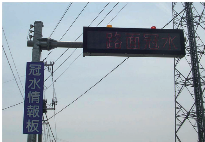
路面冠水情報板
