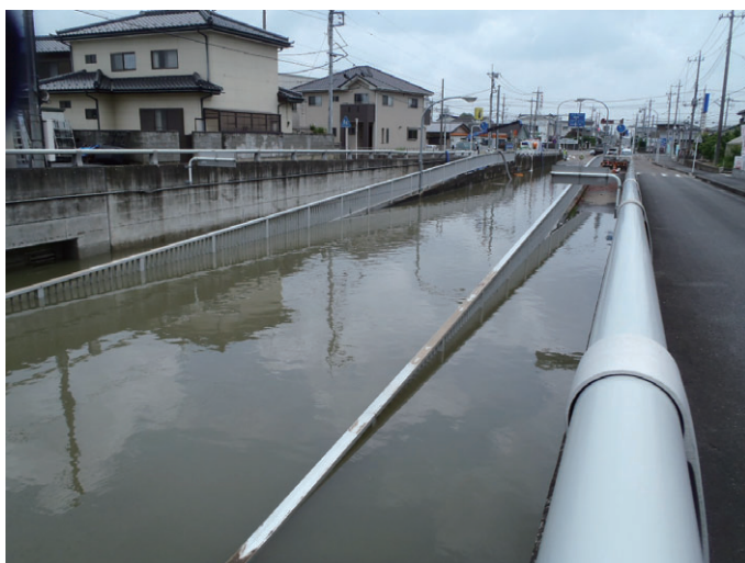
冠水した道路アンダーパス
