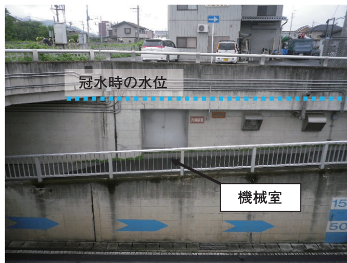
半地下構造の機械室
