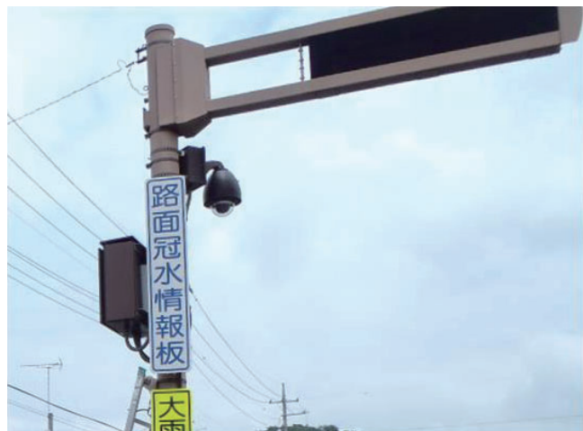
路面監視カメラ
