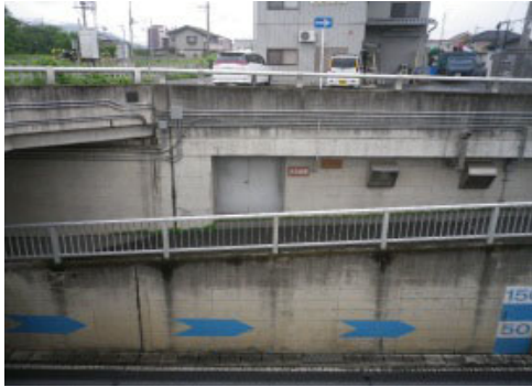
半地下構造の機械室
