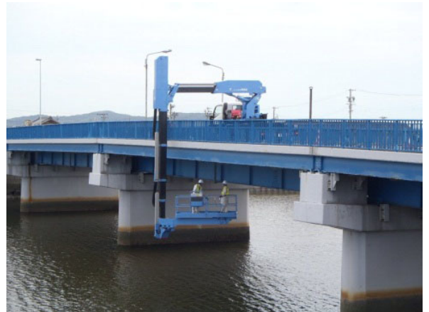
▲写真-3 橋梁の点検状況
