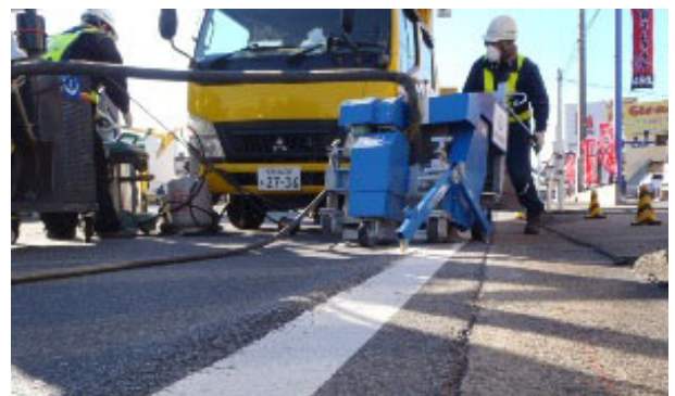
▲写真－7 こぶ取りによる不陸整正修繕の状況
