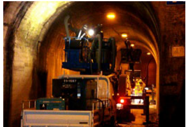
▲写真-4 トンネルの補修（背面空洞充填）状況
