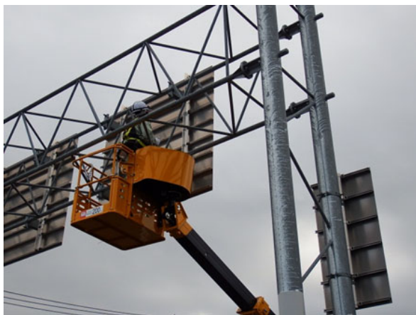
標識の点検状況
