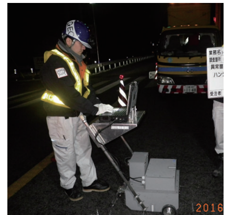
路面下空洞調査実施状況
