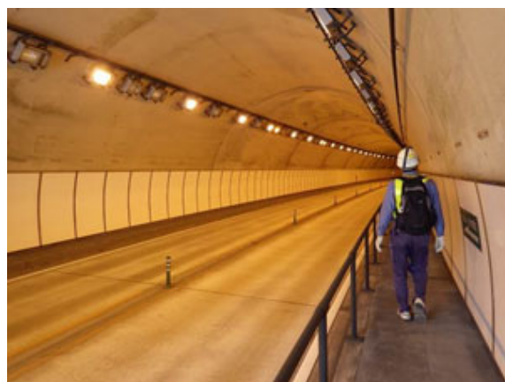
トンネルの点検状況
