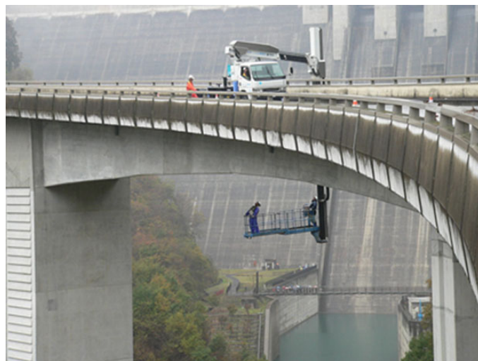
橋梁の点検状況
