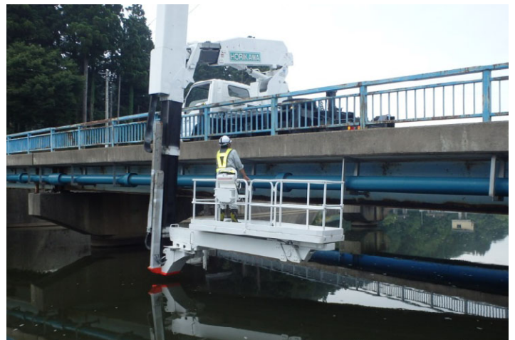
道路橋点検状況
