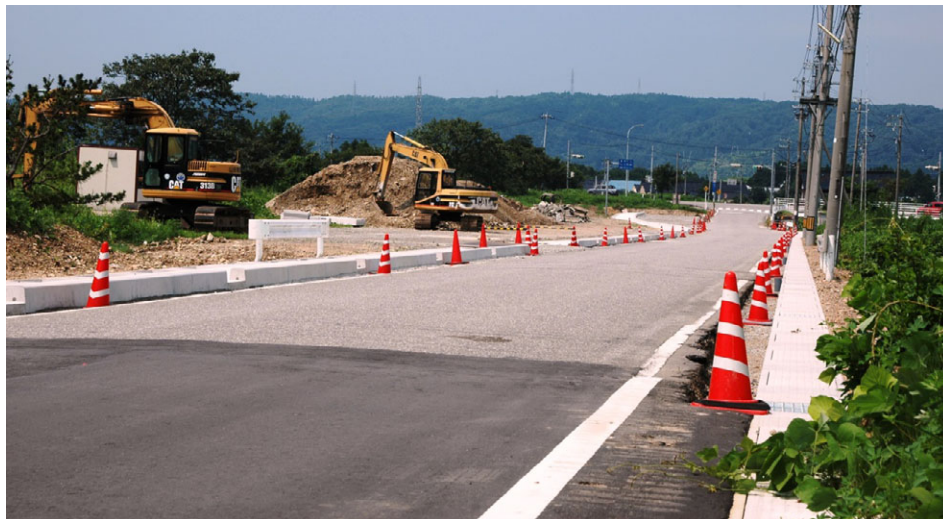
歩道設置工事
