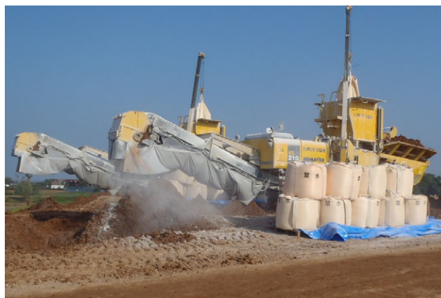
写真 3 自走式土質改良機による石灰改良
