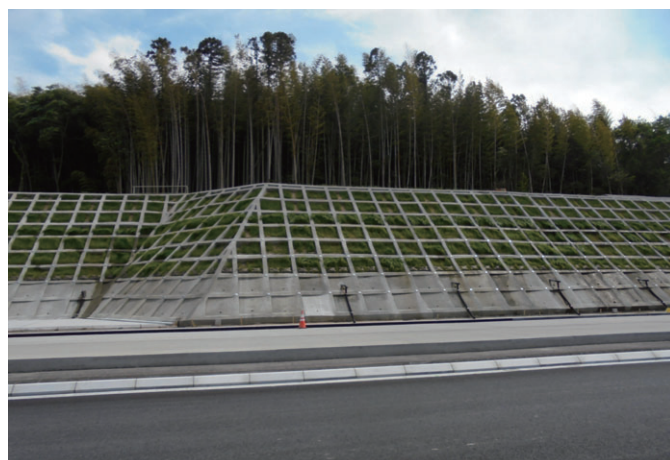
のり面補強対策状況
