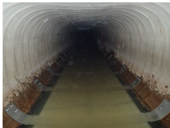
写真 5 採熱管固定状況
