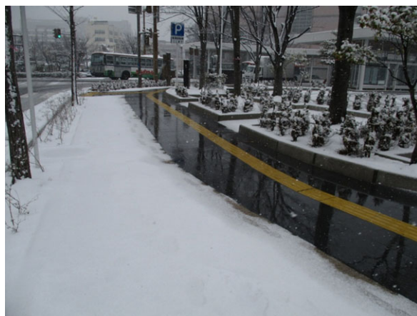
写真 7 平成 28 年 1 月 融雪状況（近景）
