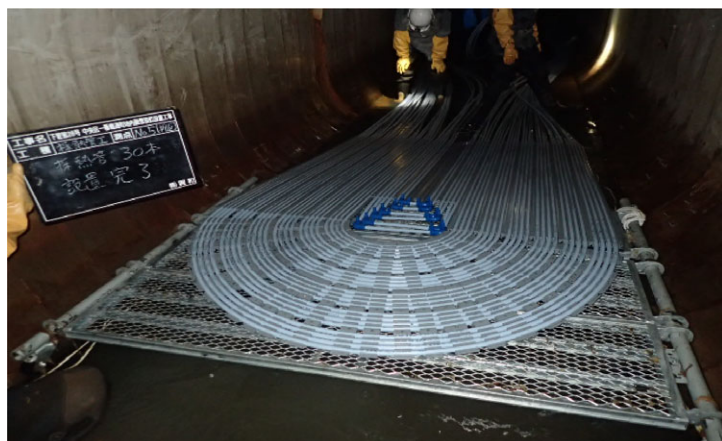
写真 4 採熱管敷設状況
